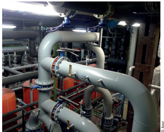
Local technique – machine à absorption
