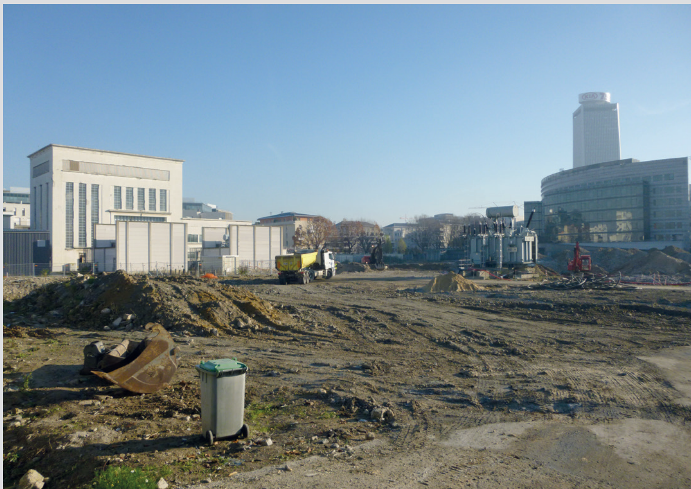
Photo de chantier à Saint-Denis Pleyel sur un foncier RTE
