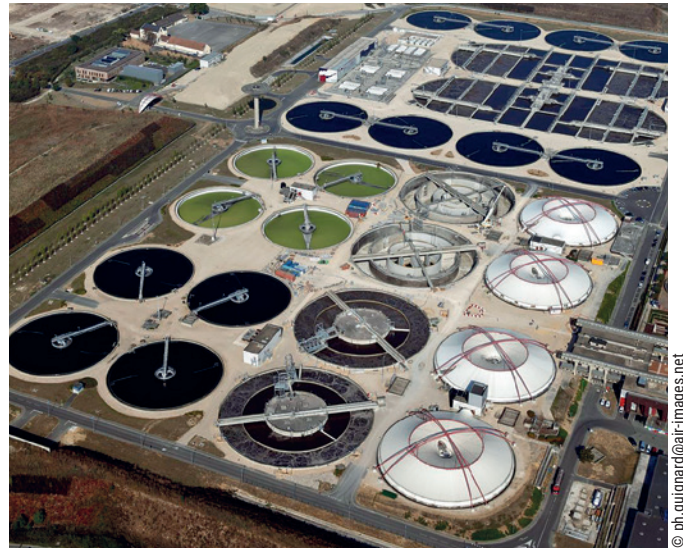
Station d'épuration de Valenton
