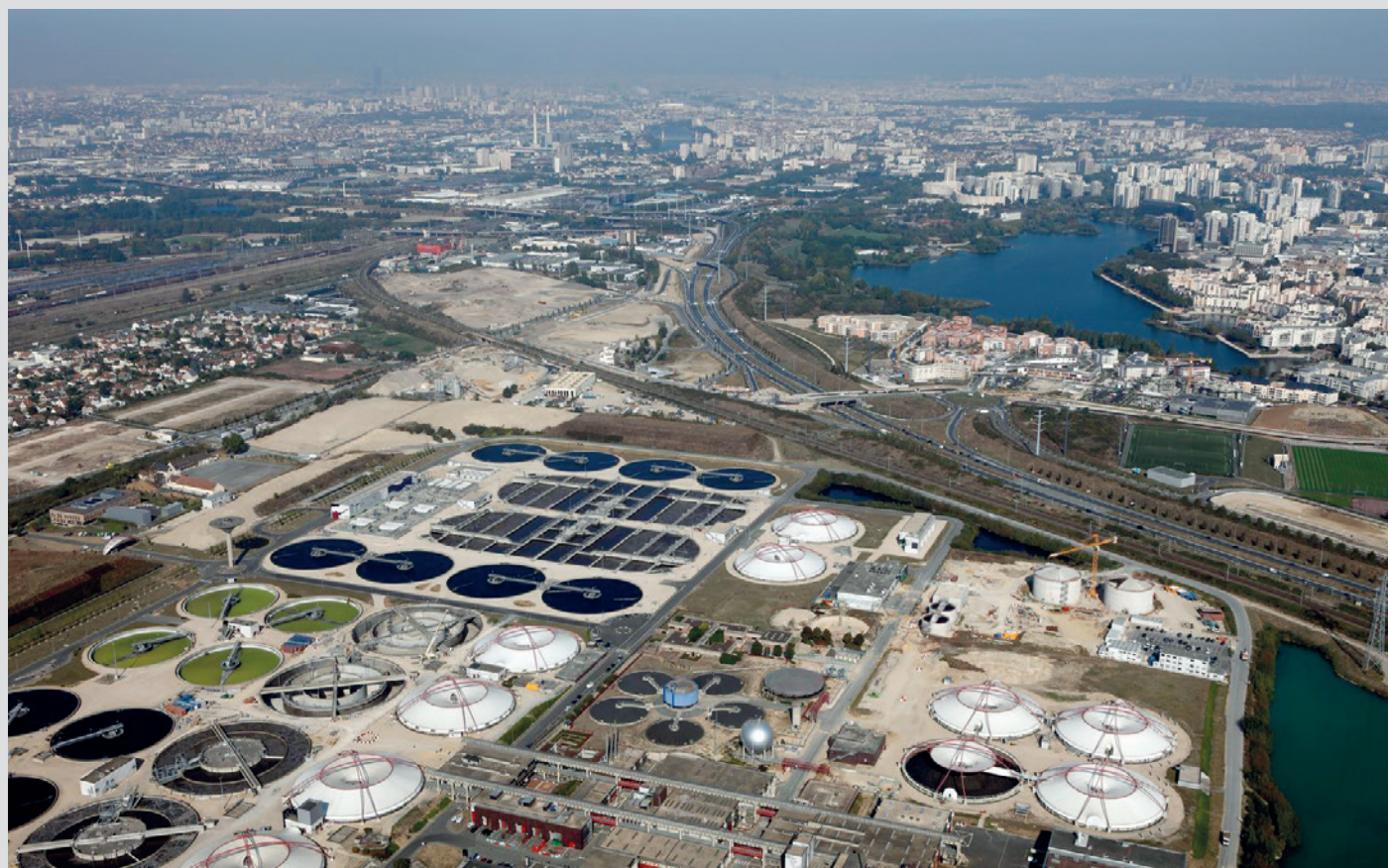
Station d'épuration de Valenton
