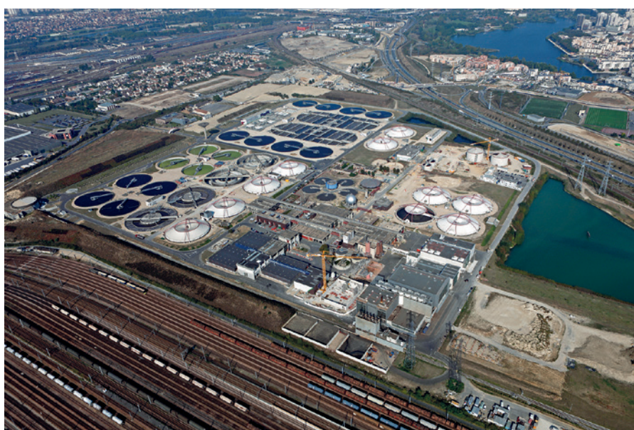
STATION D'ÉPURATION DE VALENTON
