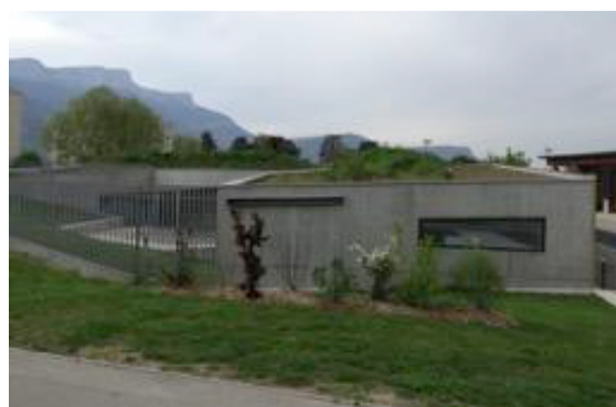
Toiture végétalisée (5 ème façade) à Saint Egrève Crédit photo : CAUE de l'Isère
