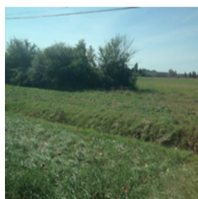
Fossé dans une parcelle participant à la gestion pluviale. Crédit photo : CAUE de l'Isère
