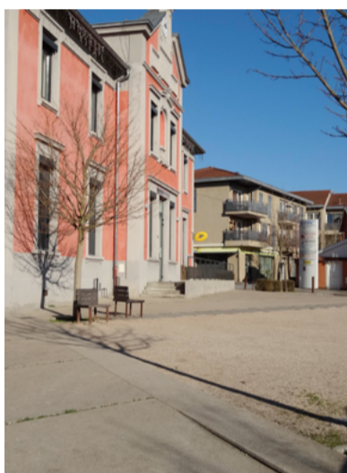
Centre-bourg réaménagé avec des surfaces perméables Crédit photo : CAUE de l'Isère
