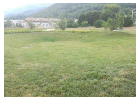
Bassin ouvert – Seyssins Source : Communauté de l'eau
