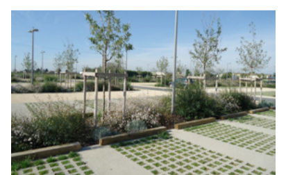
Parking perméable et noues récoltant les eaux de ruissellement - Bourg-de-Péage Crédit photo : CAUE de l'Isère
