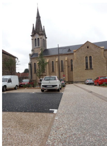
Gestion pluviale intégrée dans le parking de l'église - Saint-Marcel-Bel-Accueil Crédit photo : CAUE de l'Isère
