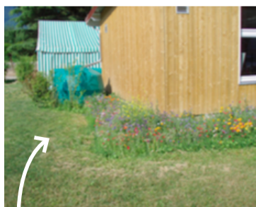
Cuve de rétention - Crêts-en-Belledonne Crédit photo : Crêts-en-Belledonne
