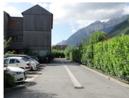
Complémentarité d'un parking perméable et d'un avaloir pour la gestion pluviale - Veurey-Voroize Crédit photo : CAUE de l'Isère
