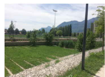
Espace de vie enherbé inondé lors de petites pluies - Voreppe Crédit photo : Communauté de l'eau
