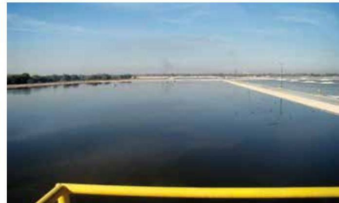
Laguna de Maduración
