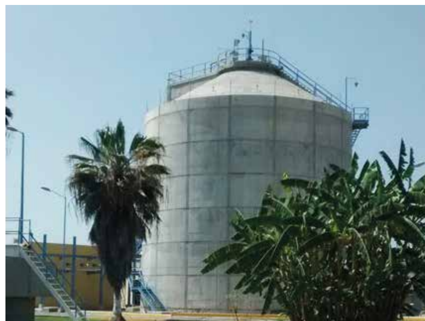
Digestor anaerobio de lodos
