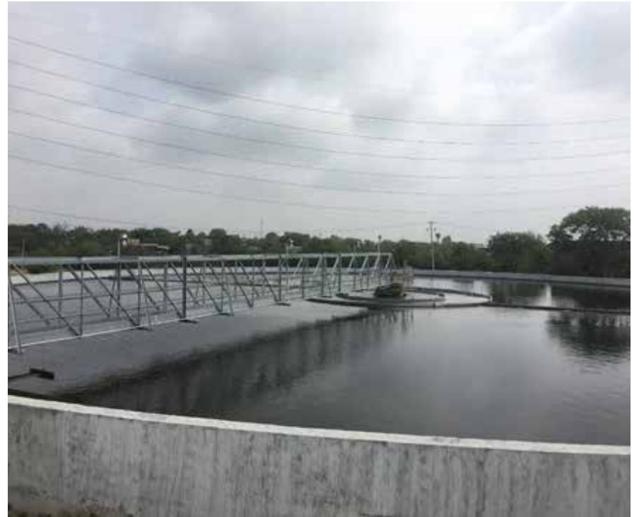
Sedimentador secundario
