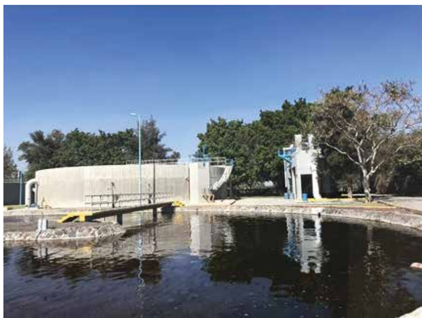
Sedimentador secundario
