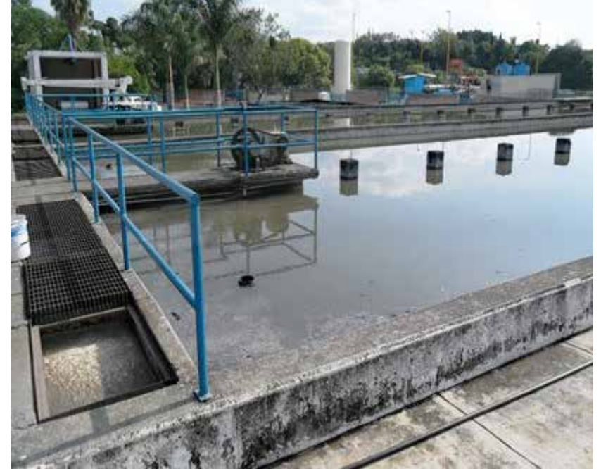
Sedimentador secundario
