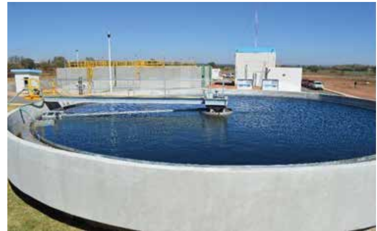
Sedimentador secundario
