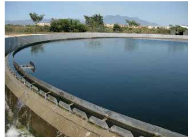
Sedimentador secundario
