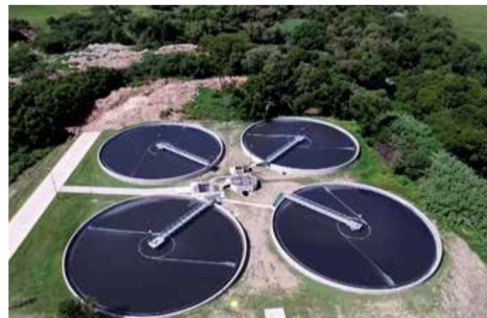
Sedimentador secundario
