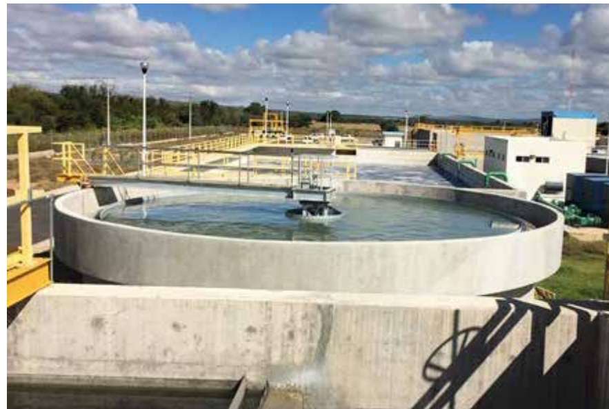
Sedimentador secundario
