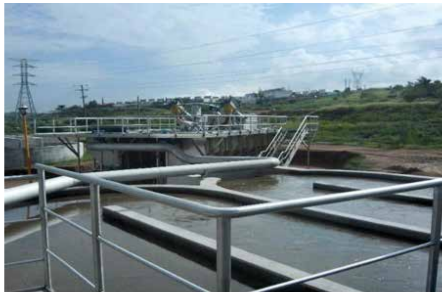
Zanja de oxidación
