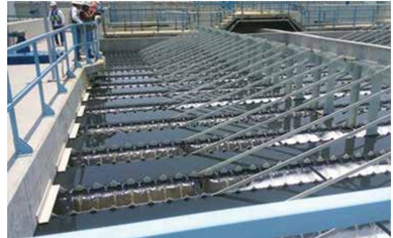
Sedimentador secundario
