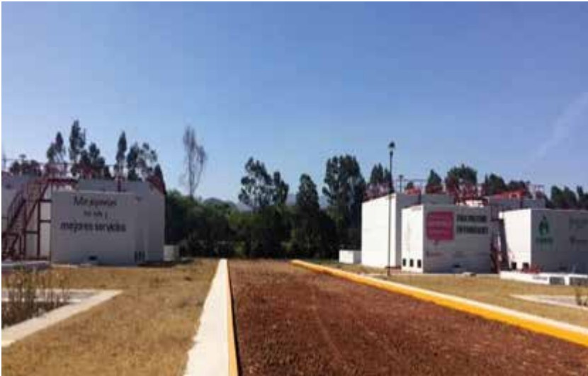
Vista general de la planta
