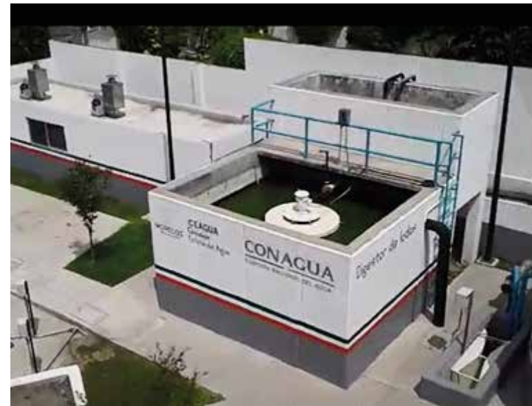
Digestor aerobio de lodos
