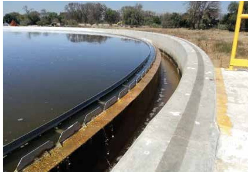
Sedimentador secundario
