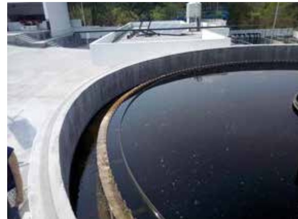
Sedimentador secundario
