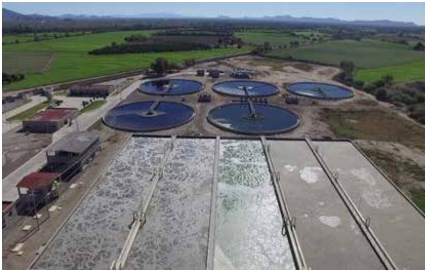
Vista aérea del sistema de lodos activados
